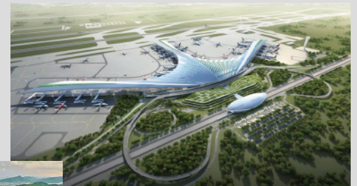
롱탄 국제공항 공사 - 동나이(호치민) LONG THANH International Airport - Dong Nai
